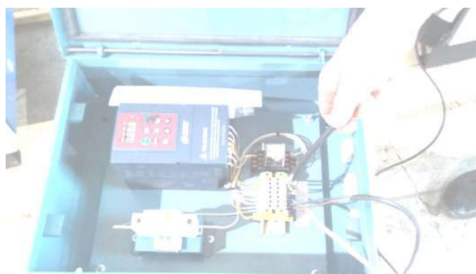
Рис.9 Подключение дымососа к БУД
