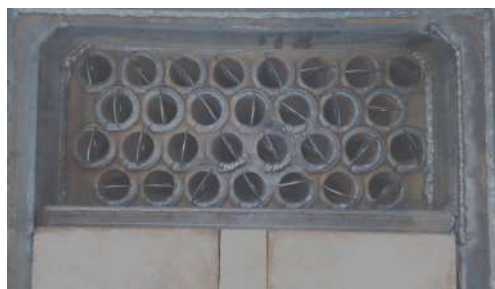
Рис. 23 Установка турбуляторов
